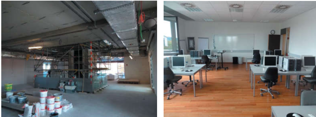
Abb. 8 und 9: Bürogebäude vor Beginn der Schimmelsanierung nach dem Ausbau von schimmelbelasteten Bauteilen
