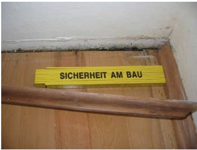
Erste Anzeichen von Schimmelbelastungen unter Bodenbelägen sind meist schon im Bereich der Sockelleisten zu erkennen.
