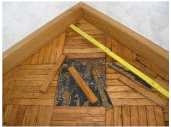
Schimmelbefall unterhalb von Bodenbelägen verlangt vollständigen Rückbau und eine detaillierte Diagnose der Entstehung.
