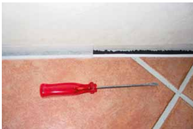
Mit dem diffusionsoffenen Estrichfugensystem können sowohl Schimmelsporen (weißes Filtergewebe) als auch gasförmige Schimmelsporen (schwarzes Adsorptionsmittel) unter schwimmend verlegtem Estrich dauerhaft von der Raumluft ferngehalten werden.
