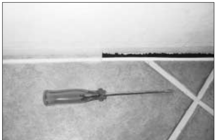
Abb. 3: Randfuge mit eingefülltem Adsorptionsmittel und Partikel bindender Membran
