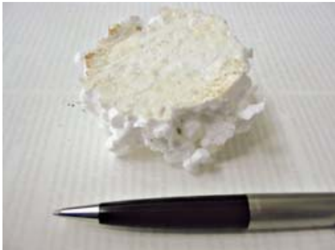
Abb. 2 Materialproben aus der Dämmebene von Fußböden zeigen häufig keine typischen Verfärbungen mit schimmelpilzartigen Strukturen, obwohl eine mikrobielle Belastung vorliegt. Erst eine mikrobiologische Untersuchung bringt Klarheit
