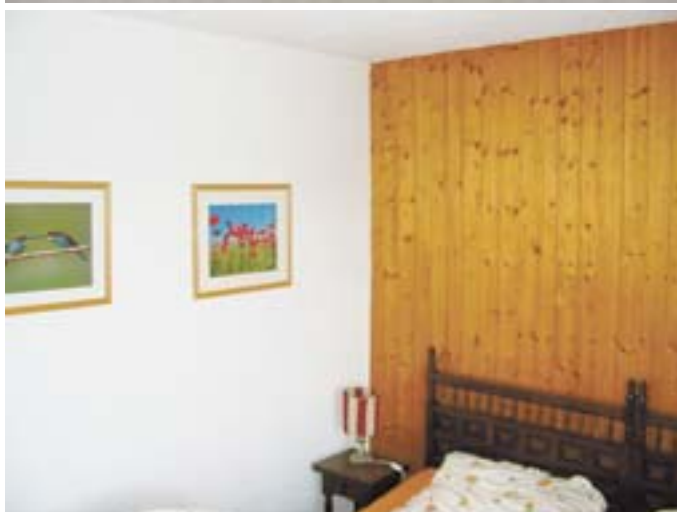
Abb. 3 Wurde die Verbretterung an der Schlafzimmerwand mit Holzschutzmittelwirkstoffen behandelt?
