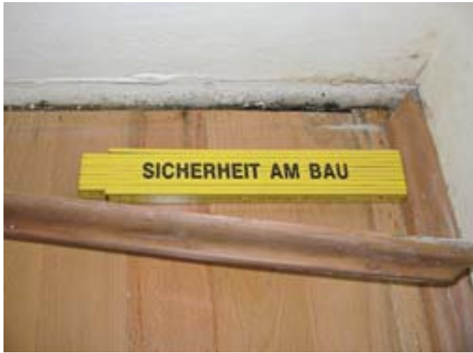
Abb. 1 Die Frage, ob ein versteckter Schimmelpilzbefall unter dem Fußboden vorhanden ist, kann im konkreten Fall nach dem Blick hinter die Fußbodenrandleiste mit »ja« beantwortet werden
